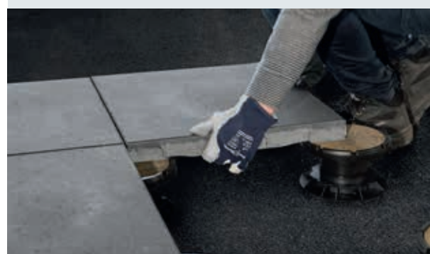
La dalle Dreen®Nxt est dotée d'un évidement en sous-face, adapté à la pose précise sur la lockplate
